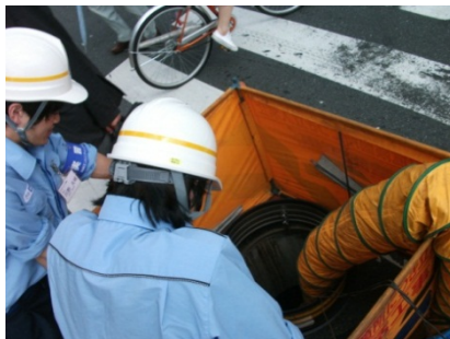
マンホール内工事の見学
