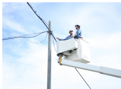
高所作業車での模擬実習
