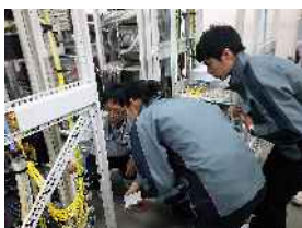
商業施設再開発工事見学
