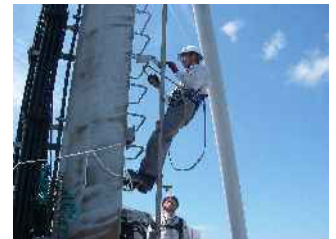
LTE基地局建設工事見学
