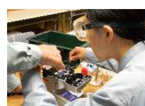
写真8. 光ケーブル接続（融着）
