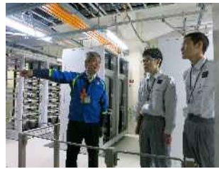
ネットワーク系工事見学
