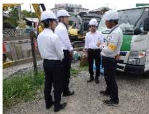
土木工事現場見学
