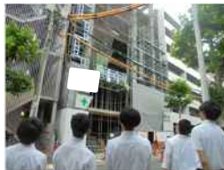
新築マンションの通信設備・電気設備工事見学
