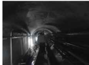
とう道補修工事見学
