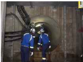
とう道補修工事見学
