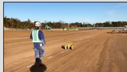
マーキング作業状況
