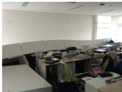
本社5階フロア(本震後) 本棚転倒
