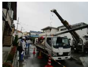
建柱作業見学
