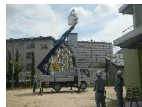
写真11. 高所作業車体感
