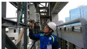
無線工事における電源ケーブル装置取付実習
