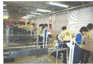
写真1. 光開通工事実習
