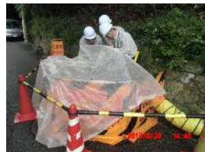
地下作業見学
