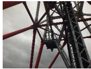
鉄塔作業実習
