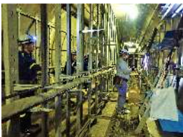
とう道補修工事見学
