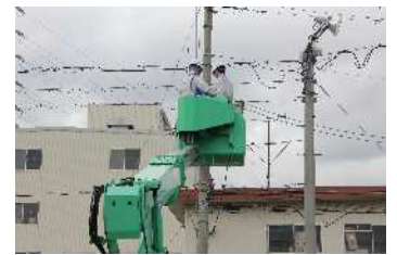
高所作業車実習
