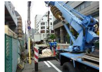
建柱作業見学
