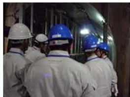
とう道補修工事見学
