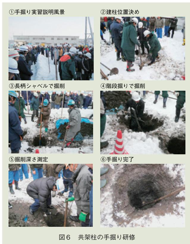
図6 共架柱の手掘り研修
