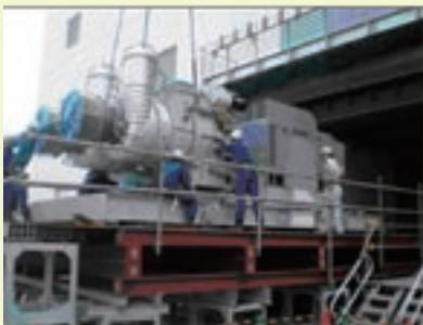
図3 非常用発電機と無停電電源装置の施工事例
