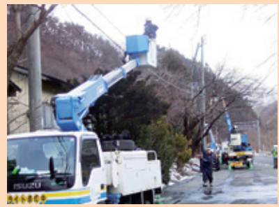
施工状況（コサインカーブハンガー）
