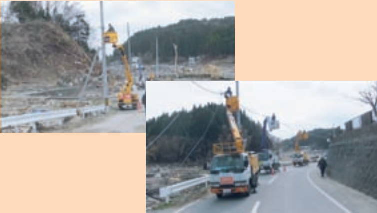
写真8 東日本大震災の復旧支援活動
