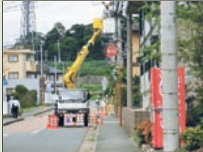
②サ総工事（技術センタ直営班による架空光ケーブル新設）
