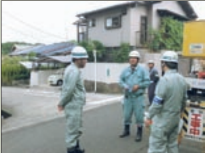
①サ総工事（架空光接続）
