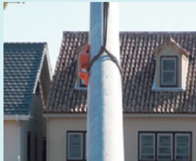
ii) 「すり止め防止具」使用による電柱吊り上げ
