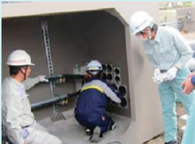
i) 狭いMH内での作業
