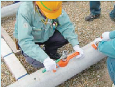
i) 「すり止め防止具」の取付け
