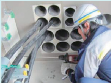
ii) 削孔ドリルによる作業
