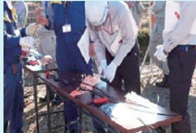
ii) 切断配線クリート取付け
