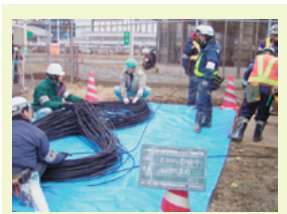
写真2 地下の光ケーブル敷設準備模様
