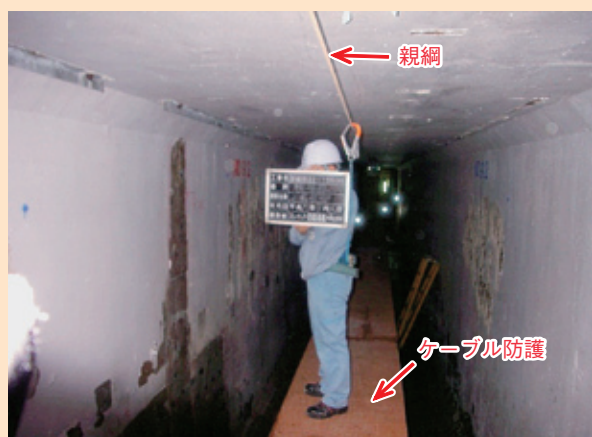
写真7 ケーブル防護状況および転落防止措置状況
