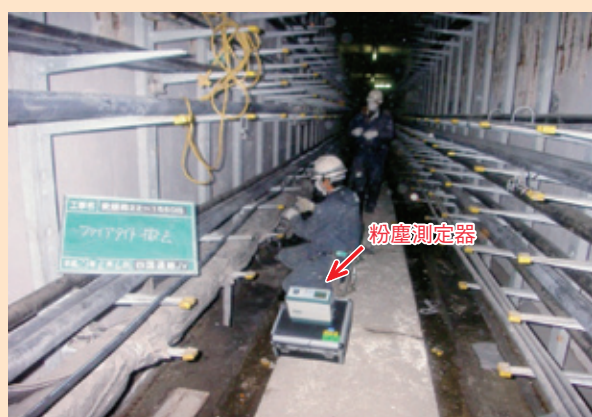
写真8 粉塵作業（ファイアタイトカバー撤去）状況
