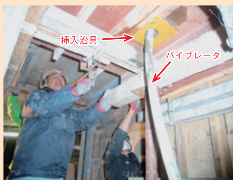
写真3 コンクリート打設(バイブレータ挿入)状況
