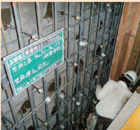
写真5 鉄筋・型枠組立作業状況
