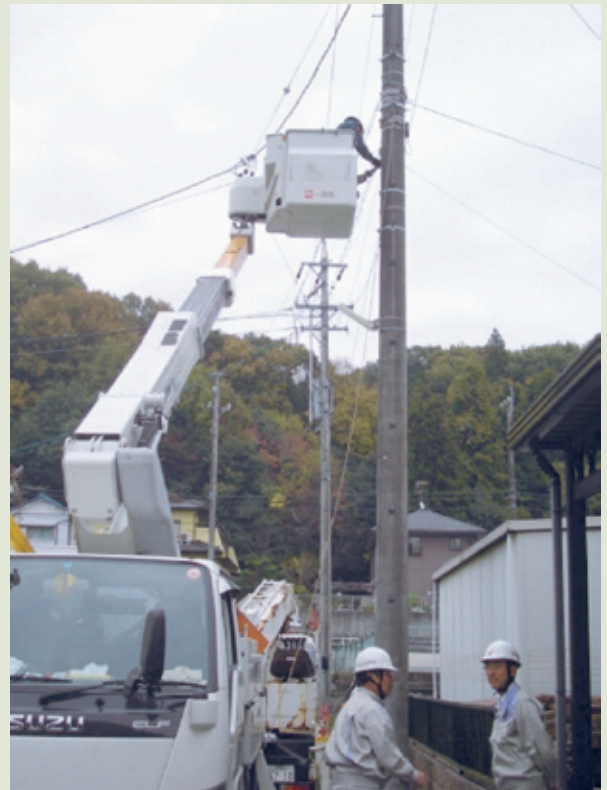
写真2 幹部による安全パトロール
