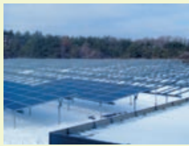
図10 スパイラル型杭に太陽光パネルを設置
