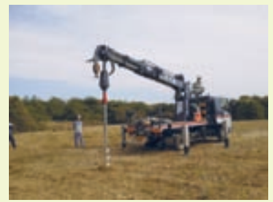
図11 アンカーSUNによる施工
