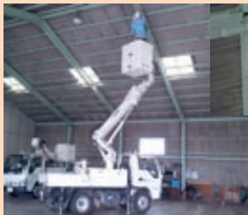
バケット車によるLED投光器の設置
