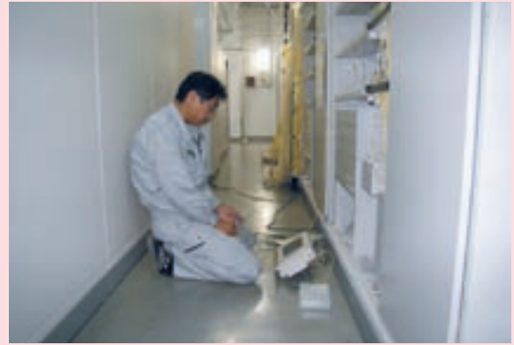
写真6 大津ビルでのパルス試験
