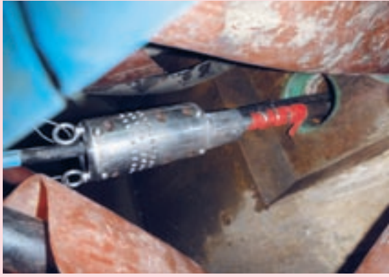
写真7 洗浄装置設置状況
