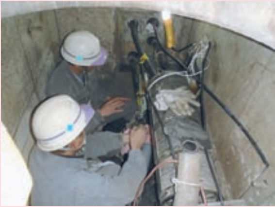
写真12 押込み側MH (手押し挿入)
