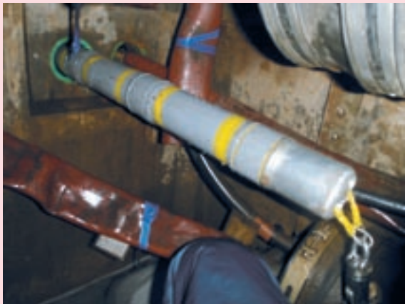
写真11 テストピース挿入状況 (部材×3)
