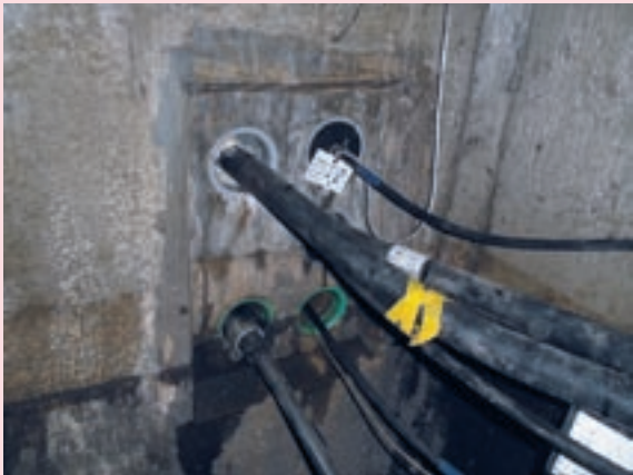
写真14 ライニング実施前
