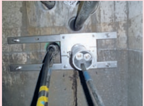
写真15 ライニング実施後
