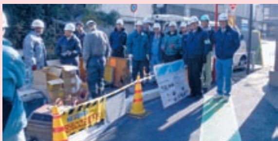
写真18 作業開始前の工法説明
