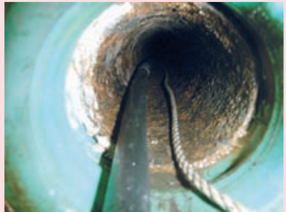
写真10 洗浄後 (No5~ No6 / No6ダクト部)
