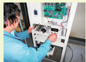
写真2 空気乾燥供給装置の点検作業
