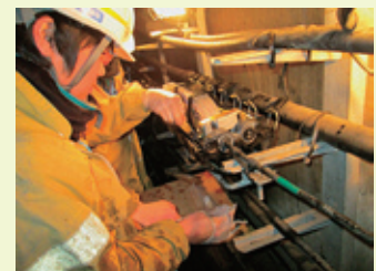
写真1 マンホール内で浸水検知モジュールの取替え作業
