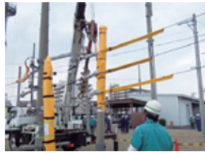
ii) 模擬電柱によるクランプカバーの損傷
