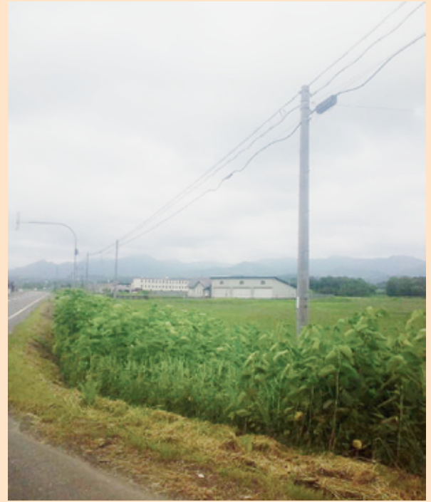
写真3 建柱位置状況（電柱から道路までの離隔約15m 高低差2.3m）
