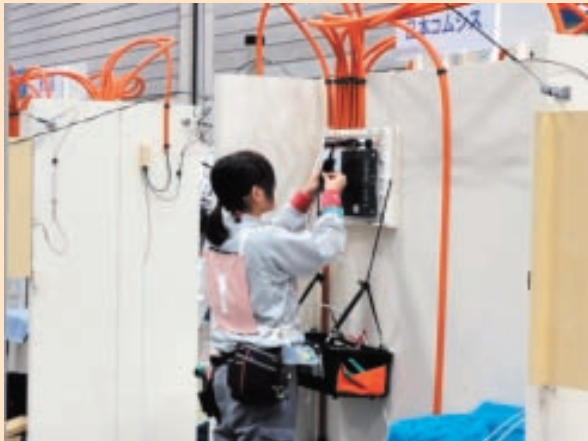
第7回光通信工事技能競技会での競技模様
