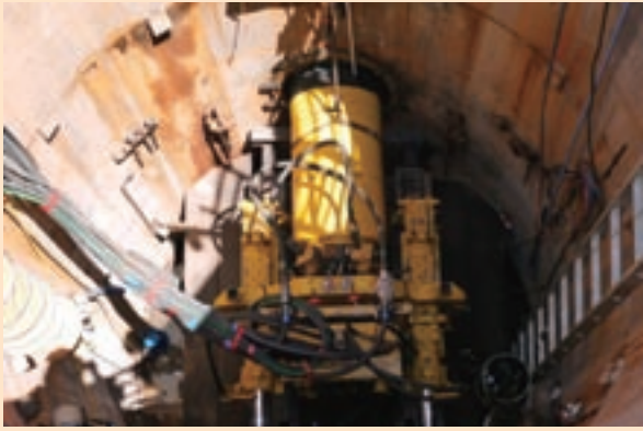
写真4 アイアンモール工法
