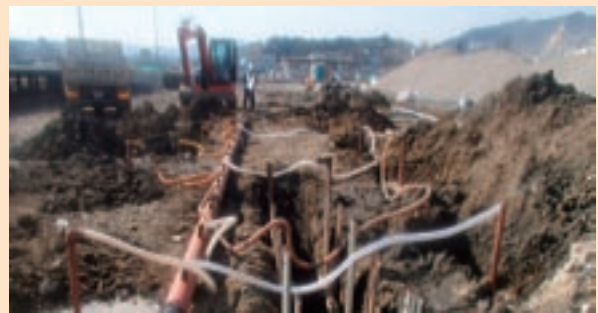
写真5 ウエルポイントによる水替え
