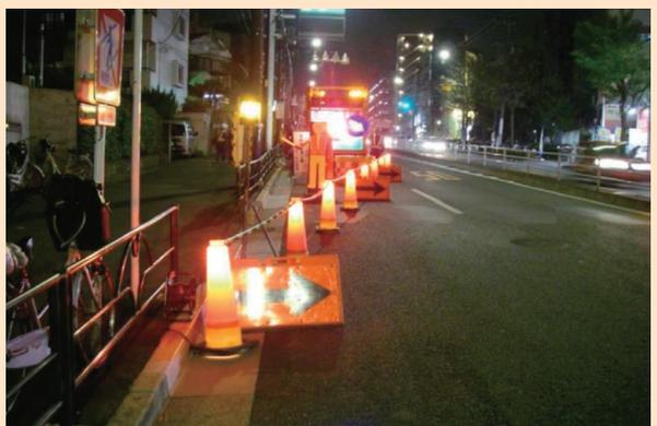
写真4 工事保安設置状況
