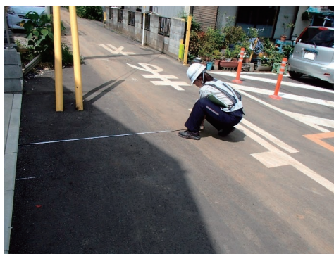
設計図作成のため、現場測量状況
