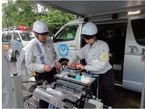
九都県市合同防災訓練における 光ケーブル接続復旧訓練
