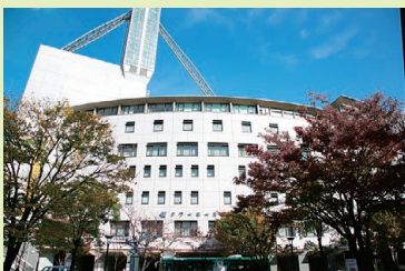
写真1 タワーホール船堀
