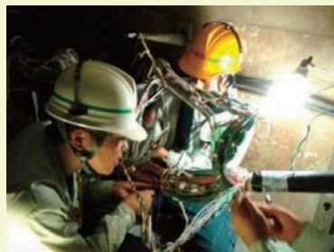
写真3 地下メタル接続OJT
