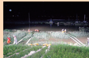
写真2 「関東・東北豪雨の水害」で夜を徹しての排水作業
