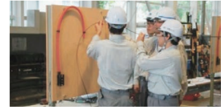
写真2 光開通工事実習
