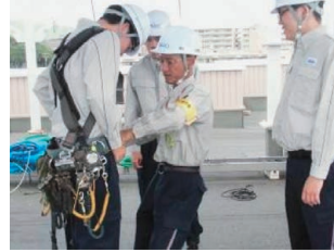
LTE無線基地局アンテナ設置工事 見学における安全対策の実体験 (株式会社協和エクシオ)
