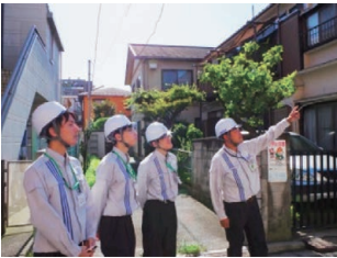
光開通工事見学 (株式会社 ミライト)
