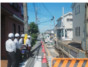
管路埋設工事現場見学 (株式会社 ミライト・テクノロジーズ)
