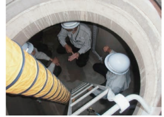
マンホール入孔体験 (株式会社協和エクシオ)
