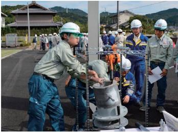
下柱建て込み、フランジ部接合、高力ボルト締め付け、の各作業を容易にするツール
