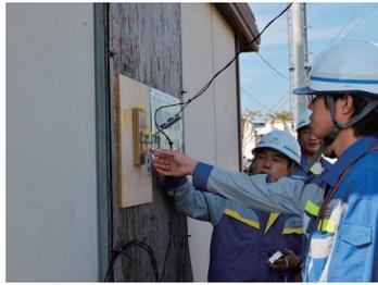
垂れ下がった屋外線の張力の体感、屋外側のC型金物壁面浮き状態体感及び安全な屋外線作業方法の改善紹介と体感
