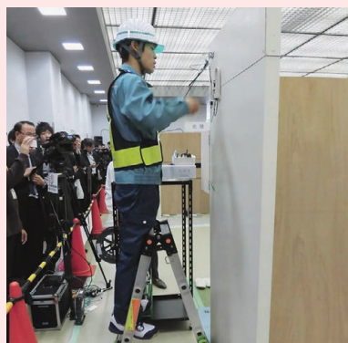
安全を確保した脚立上での作業
