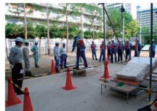
スレート屋根踏み抜き
