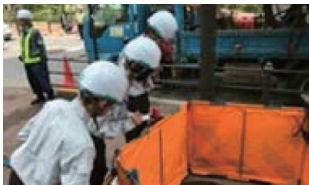
光開通工事見学 [マンホール]
