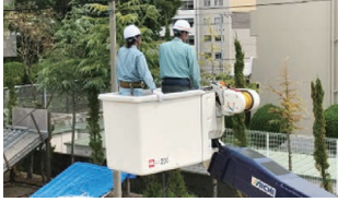
写真11 高所作業車体感
