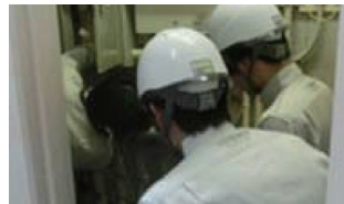
光開通工事見学 [ユーザビル内]
