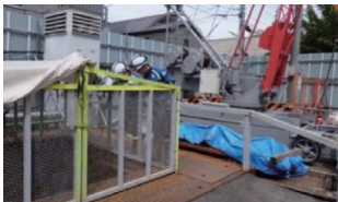
とう道補修工事見学
