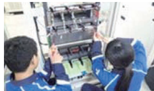
ラック取付実習
