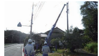
LTE無線基地局工事の見学
