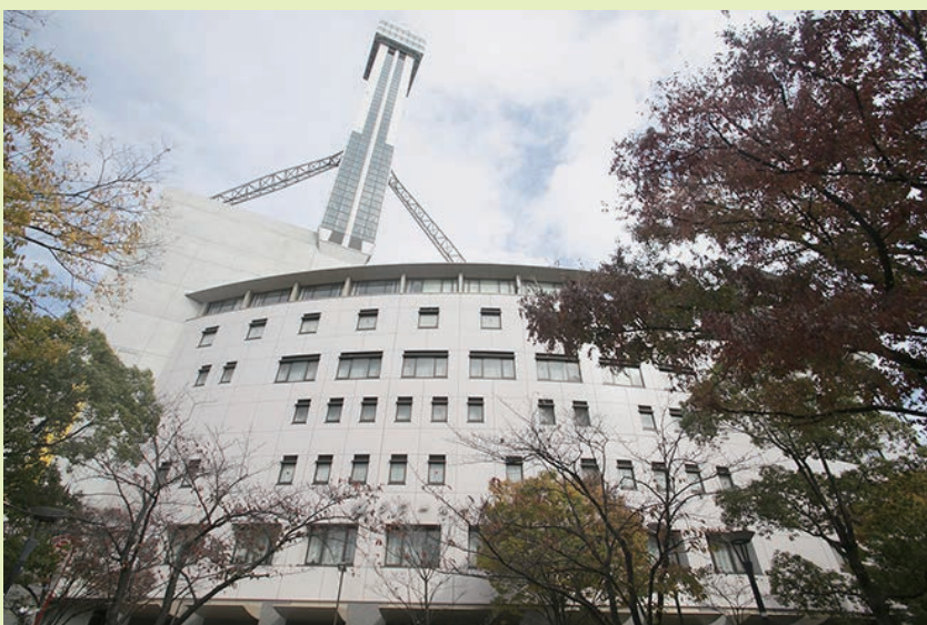
写真1 タワーホール船堀
