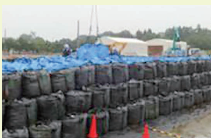
写真2 中間貯蔵設備建築箇所（土壌等整備）
