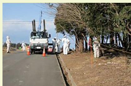
写真3 電柱・ケーブル撤去作業
