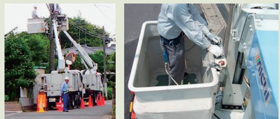
写真2 高所作業車を使った作業
