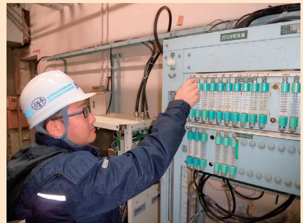
写真2 ガス供給装置点検作業
