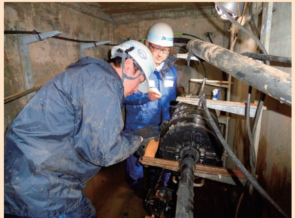
写真4 MH内での漏洩孔探索指導
