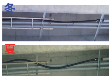
図3 気温低下とケーブル把持用ゴムスリーブの収縮
