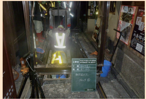
写真3 門型クレーンを使った通信柵の設置
