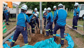
写真1 新入社員外線研修（電柱）
