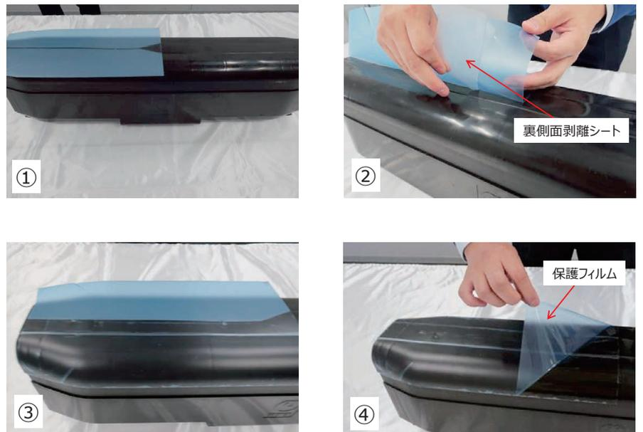
図7 着雪防止シートの施工手順
