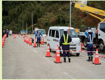
写真12 保安施設標準設置パターン実演
