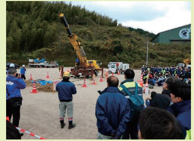
写真13 穴掘建柱車による下部支線撤去作業中の事故実演
