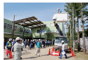
写真4 高所作業車による 保全工事（2）
