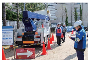
写真3 高所作業車による 保全工事（1）
