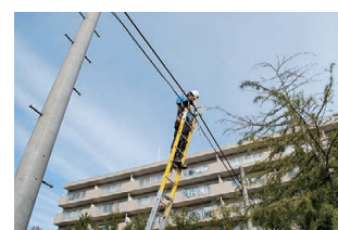
写真6 梯子作業による 開通工事（2）
