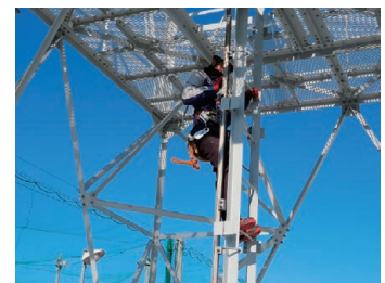
写真14 訓練用鉄塔昇降(2)
