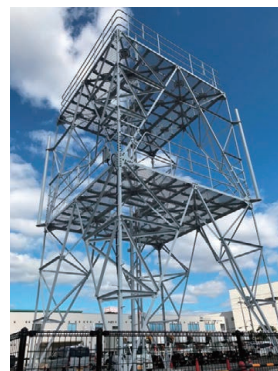
写真13 訓練用鉄塔昇降(1)
