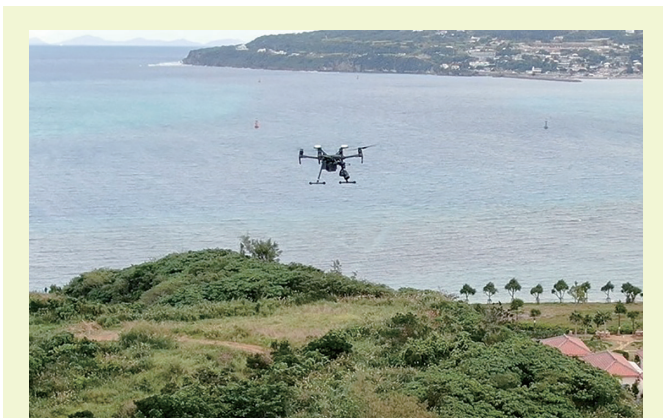
写真1 ドローンによる鉄塔点検
