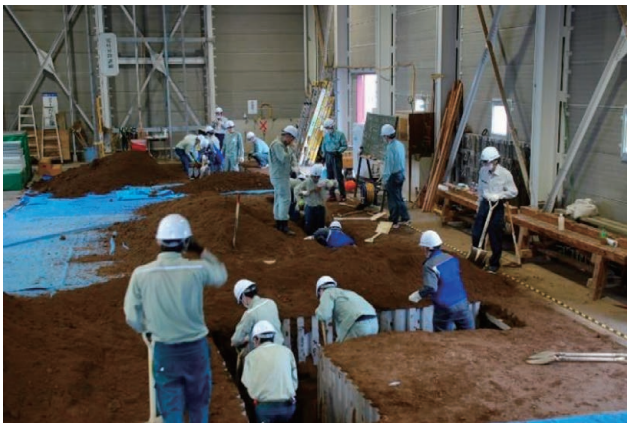
写真1 第1回基礎研修土木科 管路掘削・管布設実習 (2021.5.12~5.28)
