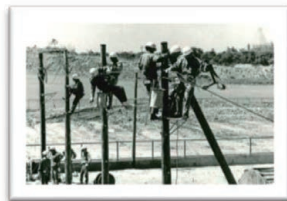
写真2 架空線路架渉 (昭和45年)
