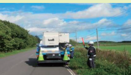
バック誘導状況
