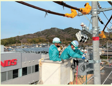
写真9 研修 トランス取付作業
