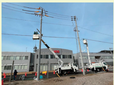
写真8 研修 ウィンチを使用したトランス吊り上げ作業
