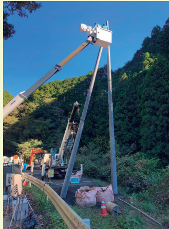
写真13 現場施工 電力共架柱建柱、支柱新設工事
