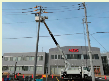
写真2 配電工事用高所作業車の配備（電力仕様作業床15m）
