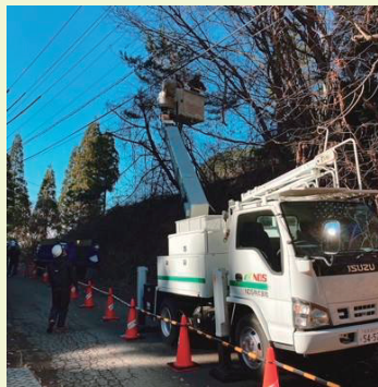
写真16 伐採作業現場
