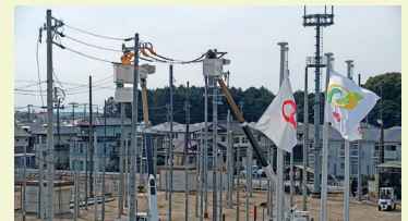
写真5 テクノロジー総合センター（現場作業を想定した配電外線研修）
