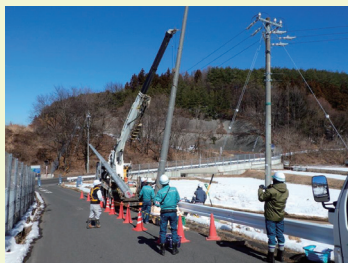
写真11 現場施工 現場責任者の立ち合い、指示の様子（電力共架柱建柱作業）
