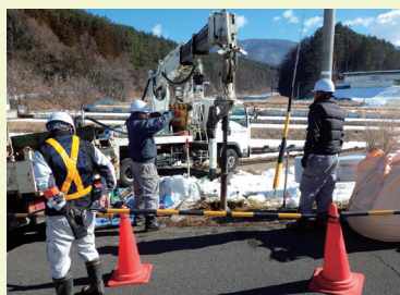
写真4 現場施工 電力共架柱建柱・支線新設工事
