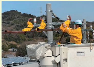
写真3 研修 高圧電線（6600V）への防護「二重防護」
