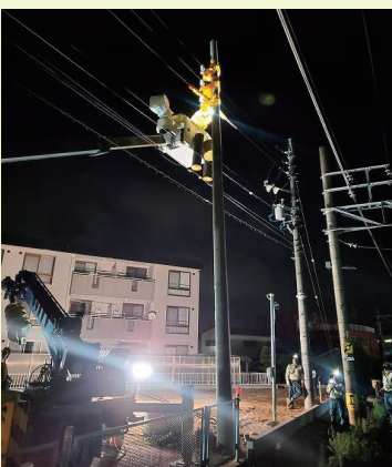
写真12 現場施工 夜間工事（高圧電線に二重防護取付と共架柱建柱作業）
