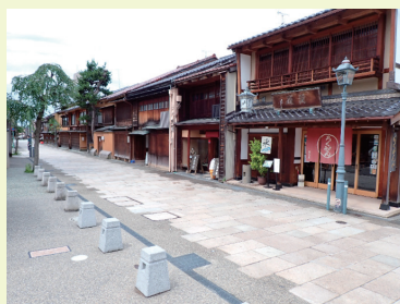
写真5 景観保全の観点から無電柱化された「にし茶屋街」
