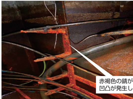
図7 マンホール内の金物腐食の様子
