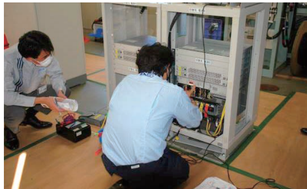
写真2 交流電源無瞬断工事研修科
